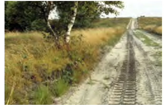
Abb. 147: Sandaufwurf durch Abschieben eines Fahrweges
